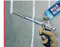
**4.** A hőszigetelő táblák a ragasztóhab felhordását követően kb. 10 percen belül az aljzatfelülethez nyomhatók. Az INSTA-STIK™ MP kötési ideje az időjárás- és nedves-ségviszonyok függvénye. A ragasztó kötési idejét célszerű az aktuális felhasználási környezetben próbaragasztással tesztelni. Nyári melegben a kötési idő 3-5 percre rövidülhet, amely növelhető víz permetezésével a felhordott ragasztóra.
