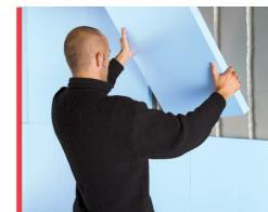
A ragasztás befejezésekor vagy megszakításakor ügyeljünk arra, hogy a kinyomópisztoly nyílása zárva legyen. A ki nem keményedett ragasztóhab a Dow 'Great Stuff™ Pro Gun Cleaner' tisztító spray termékével eltávolítható, amely a kinyomópisztoly tisztítására is szolgál. A megsilárdult ragasztó mechanikai úton távolítható el.
