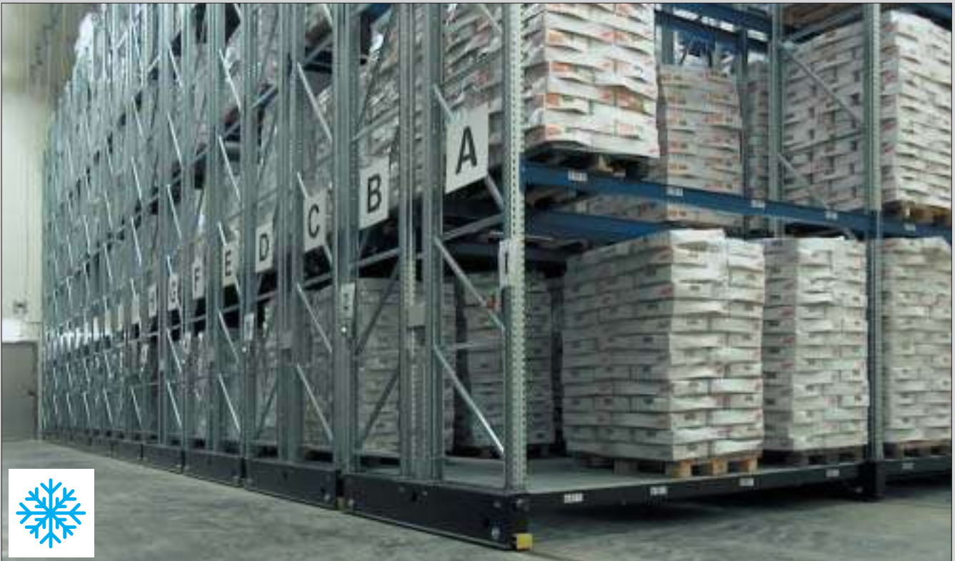
Mobil állványok hűtőházban, -28^{\circ}\text{C} hőmérsékleten.
