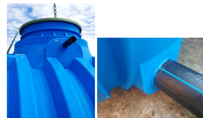
Hegesztett KPE csőcsatlakozások
