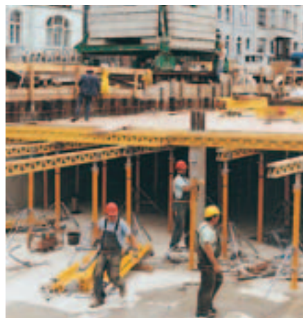
Mélygarázs építése duplázott GT 24 főtartóval. A MULTIPROP támaszok bírják a nagy terhelést. Az eredmény gyors zszaluzás az alacsony elemszám miatt.
