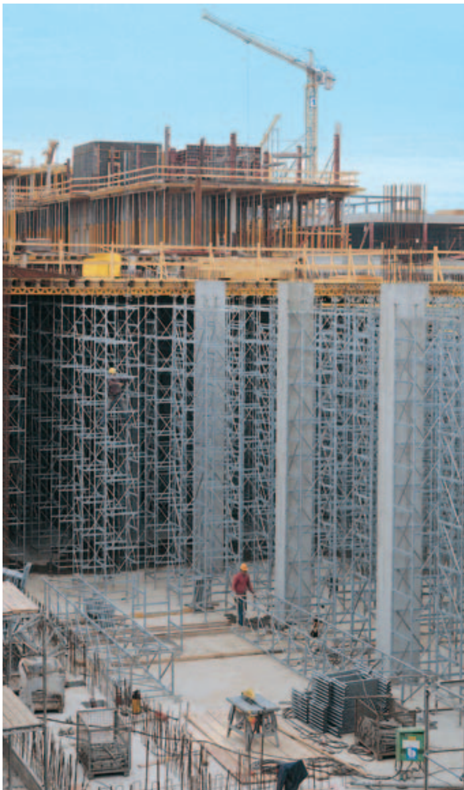
Az ST 100 máglyatorony előszerelése a földön elfektetve történhet.
