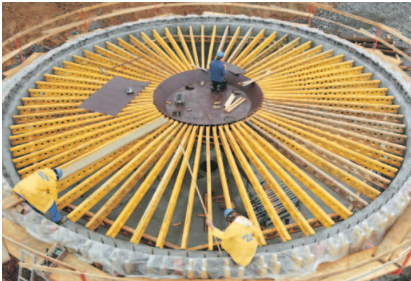
MULTIFLEX GT 24 alkalmazása egy 11,60 m átmérőjű, kúpos födémű, íves falú tárolónál.
