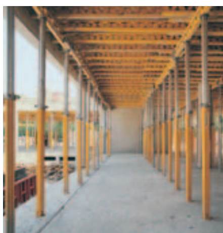
MULTIPROP MP 350 alkalmazása GT 24 fő- és keresztartóval, MULTIFLEX födémzsaluzatnál.
