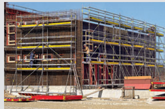
Állványok betonacél szereléshez
