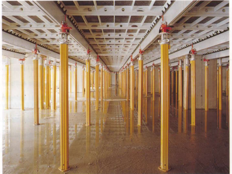
A nagy, 1,50 x 2,30 m-es támasztávolság időmegtakarítást jelent és szabad mozgást tesz lehetővé a különféle anyagok szállításakor.
