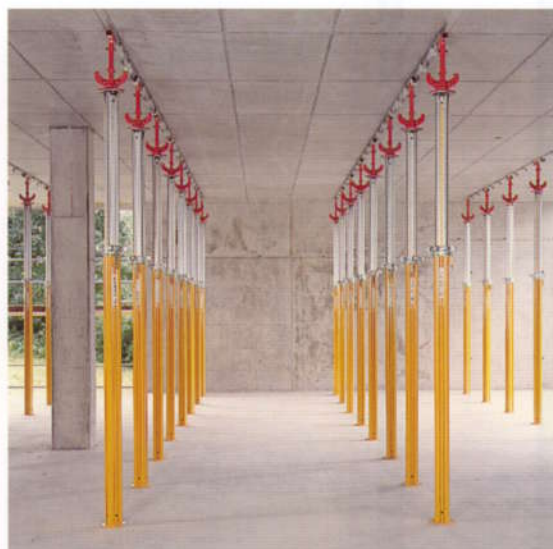
A kizsaluzás után csak az ejtőfejes támaszok és a fedőprofilok maradnak.
