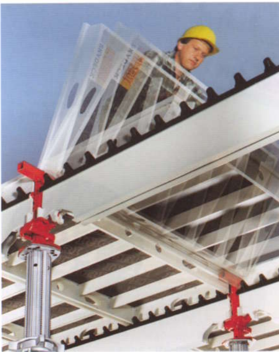
SKYDECK panelok felülről beszaluzva.
