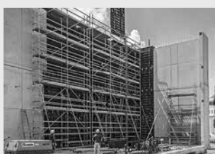
Állványok betonacél szereléshez
