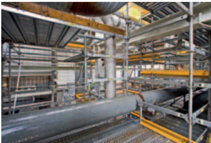
A korlátok és láblemezek a helyi adottságokhoz igazíthatók.
