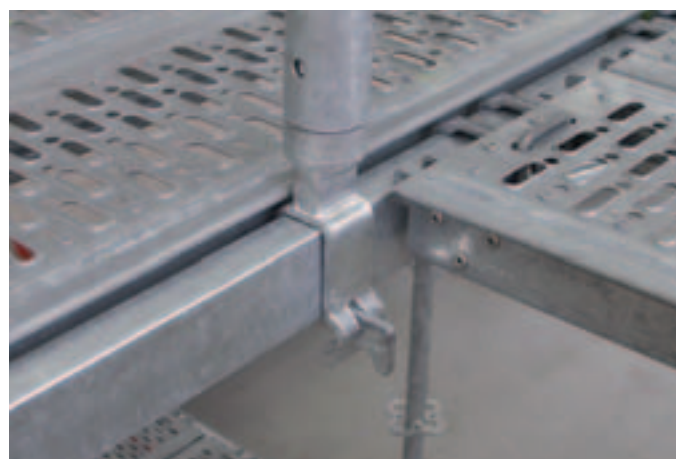
Rúdelem-a-hevederhez csatlakozás.
