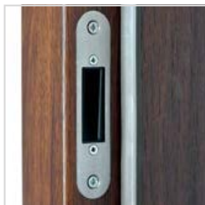
a mágneszár ellendarabja állítható
