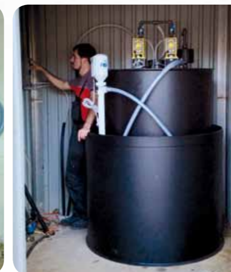
Szennyvíztelep- hypo átfejtése
