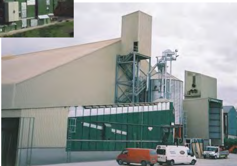
↑ Tipikus farmgazdasághoz méretezett szárítástechnika - DF 17750 szárító - 19,5 t/h
