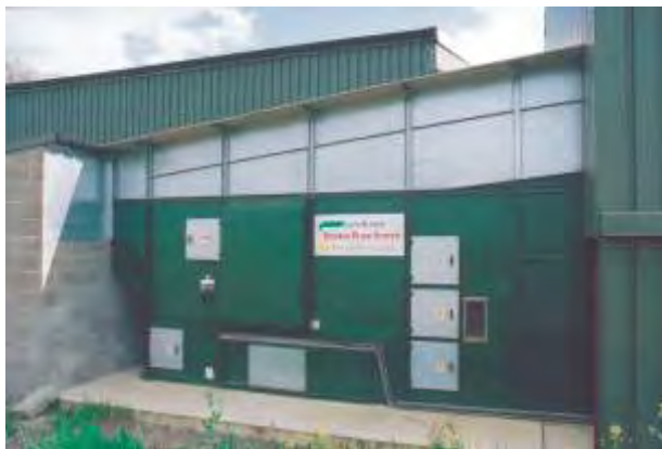
DF 17750-es 19,5 t/h kapacitású szárító - külső porkamrával szerelve
