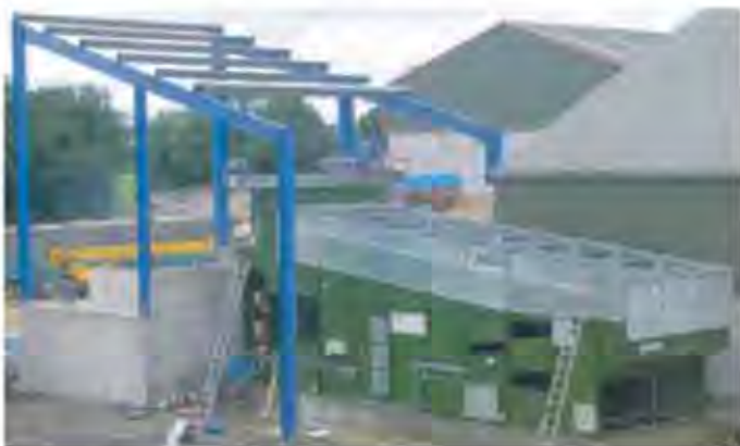
DF 30000 - 33 t/h teljesítményű szárító beüzemelés közben
