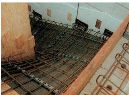
8. A vasalatot megfelelő távolságtartókkal rakjuk le és rögzítjük (42 fm 8 mm-es köracél és kb. 8 m 2 vasalat Q131)
