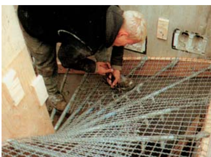
6. A flexibilis hullámrácsokat a teleszkópcsövekre rakjuk, és csavaró huzallal rögzítjük.
