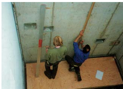
1. A méretezés irány- és méretléccel történik.
