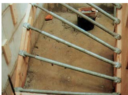
5. A teleszkópcsöveket az élfához letről felfelé haladva rögzítjük.
