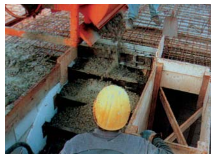
10. Ezt követően B25-0-16-os szemcséjű betont öntünk 35-40 cm-es szétterülési mérettel a lépcsőfokokba.
