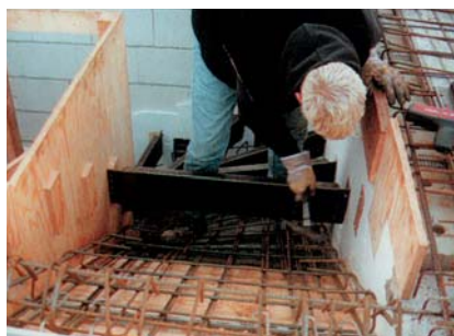
9. A kihúzható horganyzott lépcsőfokokat 65-ös szögekkel rögzítjük a lépcsőfokkevedereken.
