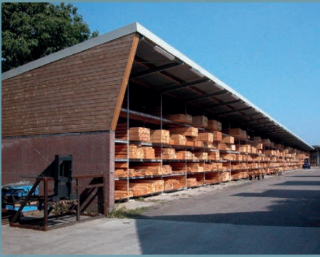
Három oldalon zárt raklappolc-csarnok fa tárolásához különböző választékokban és mélység méretekben Nagy tetőtűlnyúlás.
