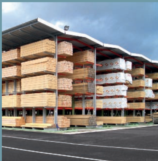
Állványcsarnok egy nagy fakereskedőnél. Tetőfedés acél trapézlemezről, ablakokkal megszakítva. Keskeny folyosós raktárként, vezetősínnel tervezve.
