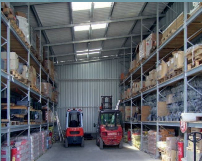
Raklappolcos csarnok egy építőanyag-kereskedőnél. Komplet, acél trapézlemezéből készült tetővel és fallal. Guruló kapuval és fénykupolákkal együtt. Az állványkeretek kiegészítő védelme ütközési erők ellen.
