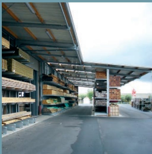
Teljesen zárt állványcsarnok kiegészítő nyitott melléképülettel, egy tetővel fedett, kétoldalú karos állvány sorral. Bejáró feletti világítással és ablakokkal együtt.
