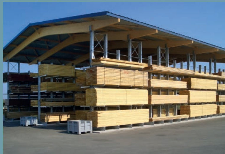
Nyitott karos állványrendszerű csarnok három dupla soros horganyzott karos állványrendszerrel. Modern nyeretgetős konstrukció 10 m fesztávval.
