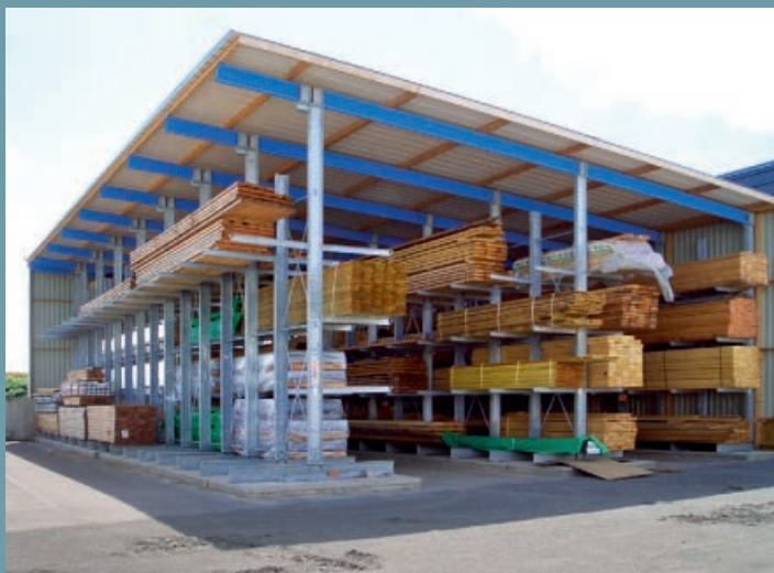
Félig zárt karos állványrendszerű csarnok horganyzott polcokkal. Tető és fal acél trapézlemezből. Egy meglévő csarnokhoz harmonikusan illő melléképület.
