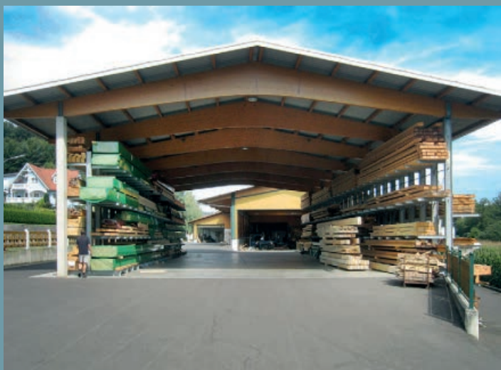
Nyitott karos állványrendszerű csarnok két dupla soros horganyzott karos állványrendszerrel. Modern nyeregtetős szerkezet trapézlemez fedéssel. Nagy alaplap.
