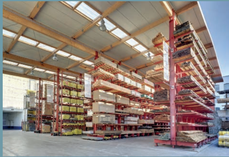
Nyitott állványcsarnok. Karos állványrendszerek és raklappolcok tető hordszerkezetként való kombinációja. Fénnyel elárastva, nagy fesztávval a teherautó átjáróhoz.
