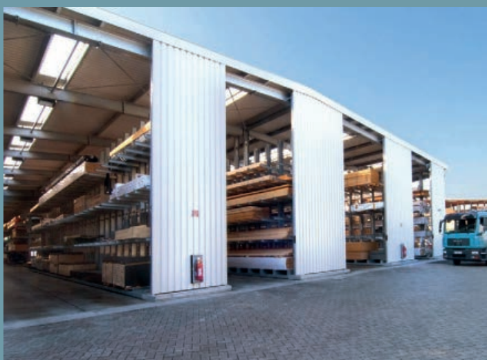
Tető- és falburkolattal ellátott faraktár. Vezetősínnel ellátott teljesen horganyzott karos állványrendszerek keskeny folyosós raktárként. Ablakos minden folyosón.
